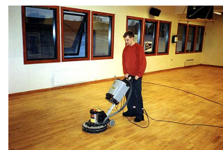
2. Nedmatting av gulvet
