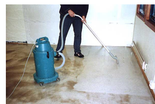
3. Det skitne vannet suges opp med en vannsuger
